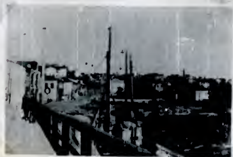
3 Blick vom zweiten Teil der Holz-doppelbrücke über d. Bug (siehe auch Bild 5 u. 6) stadteinwärts nach N. Nach rechts biegt die Uferstr. mit Strassenbahngleisen.
